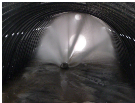
Bild 15: Hochdruckspülreinigung
