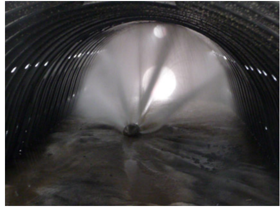
Bild 4: Spüldüse beim Reinigungsvorgang
