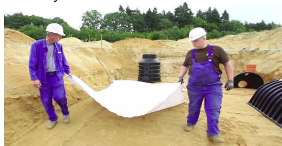
Bild 7: Geotextilgewebe im Bodenbereich
