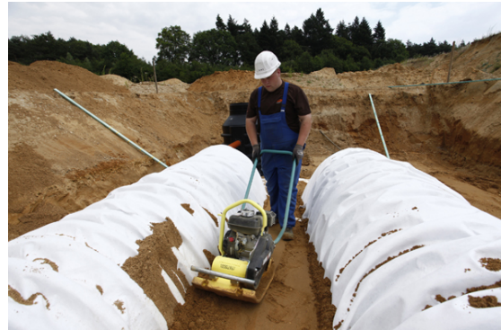
Bild 12: Verdichten mit kleinem Verdichtungsgerät zwischen den Tunnelreihen
