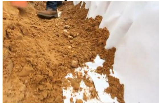
Bild 11: Anschütten des Geotextils zur Fixierung
