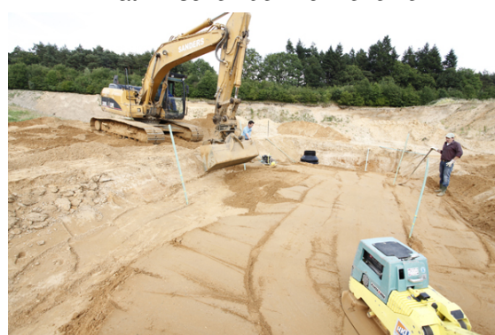
Bild 13: Überdeckung der Tunnelelemente
