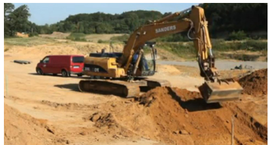
Bild 5: Ausheben der Baugrube
