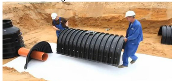
Bild 8: Anschluss an den Zulaufschacht
