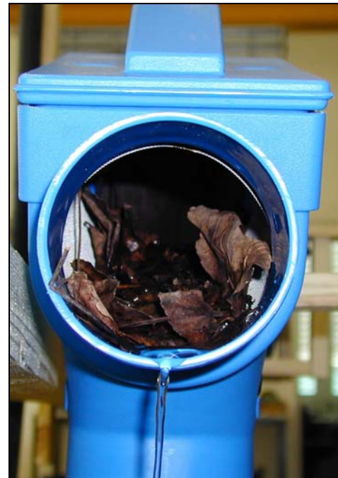
Abbildung 12: (links) 3P Patronenfilter PF mit Q = 0,2 \text{ l/s} und Verschmutzung (Laub)
