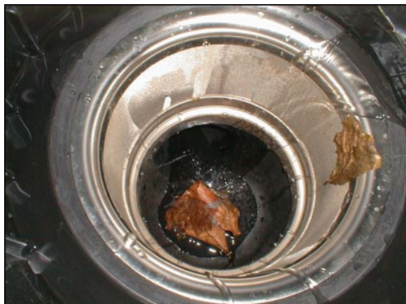
Abbildung 22: (links) WISY Wirbel-Fein-Filter mit Verschmutzung (Laub)
