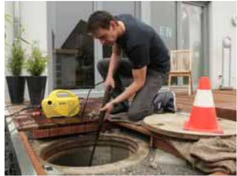
Abb. 15: Reinigung der Siebfläche mit dem Hochdruckreiniger
