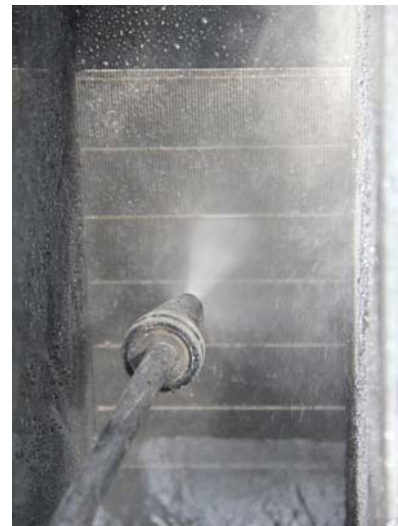
Abb. 26: Reinigung der Sieboberfläche mit Hochdruckreiniger
