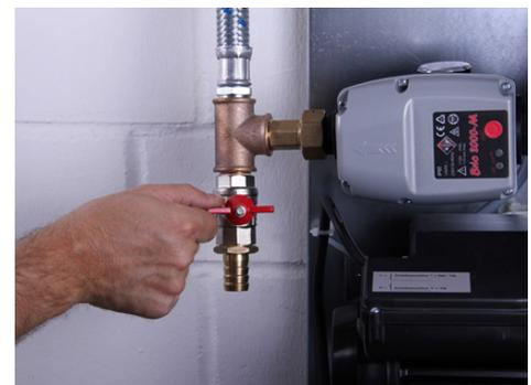
6. Druckabsperrhahn öffnen und Leitung bis zu den Verbrauchern entlüften (z.B. mehrmals Toilettenspülung drücken und Gartenhahn öffnen)
