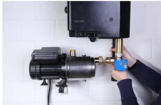
Das Trinkwasser-Nachspeiseventil wird mit dem Ventilanschlusswinkel an der Wand verschraubt.
