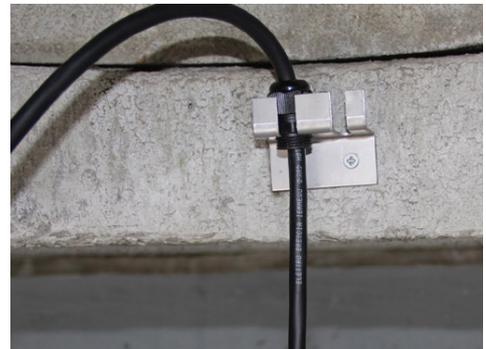
Das Kontergewicht des Schwimmschalters wird mit Abstand  $A = 15 \text{ cm}$  oberhalb des Schwimmschalters fixiert, damit sich der Schwimmschalter frei um das Kontergewicht bewegen kann.
