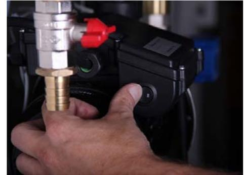
3. Druckabsperrhahn schließen.
