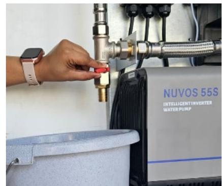
7. Druckabsperrhahn öffnen und Leitung bis zu den Verbrauchern entlüften (z.B. mehrmals Toilettenspülung drücken und Gartenhahn öffnen).
