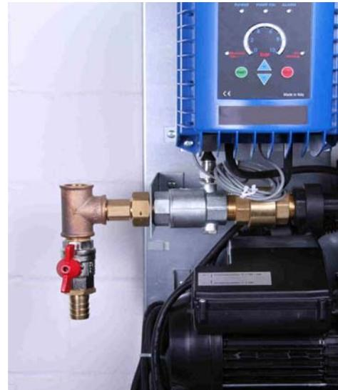
Der Druckabsperrhahn und der Flexschlauch werden mit dem Drucksystem verbunden.
