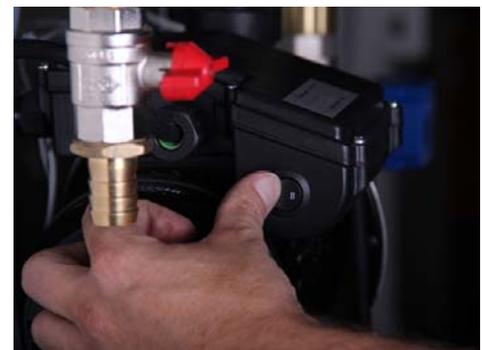
2. Druckabsperrhahn schließen.
