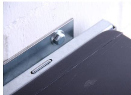
Die mitgelieferten Gummipuffer werden rückseitig in die unteren Ecken der Metallrückwand eingeschraubt.
