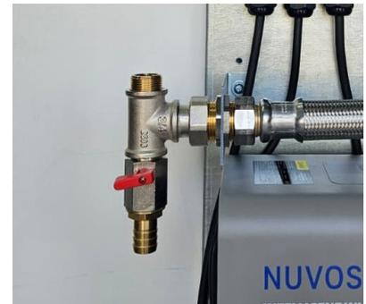
Der Druckabsperrhahn und der Flexschlauch werden mit dem Drucksystem verbunden.
