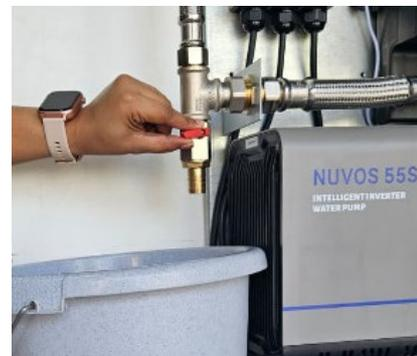
6. Druckabsperrhahn öffnen und Leitung bis zu den Verbrauchern entlüften (z.B. mehrmals Toilettenspülung drücken und Gartenhahn öffnen).
